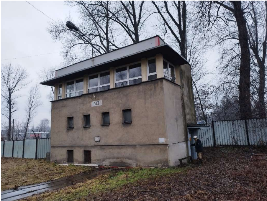
1. Budynek nastawni dysponującej WJ
