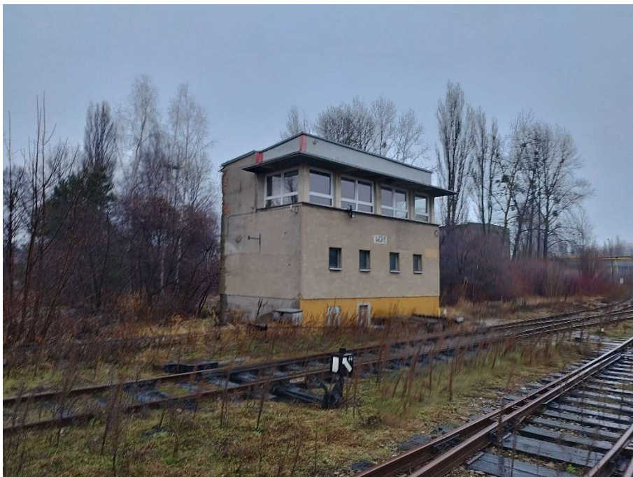
2. Budynek nastawni wykonawczej WJ1
